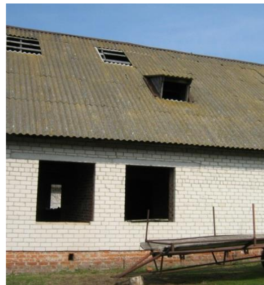
Одноквартирний житловий будинок з господарським блоком
