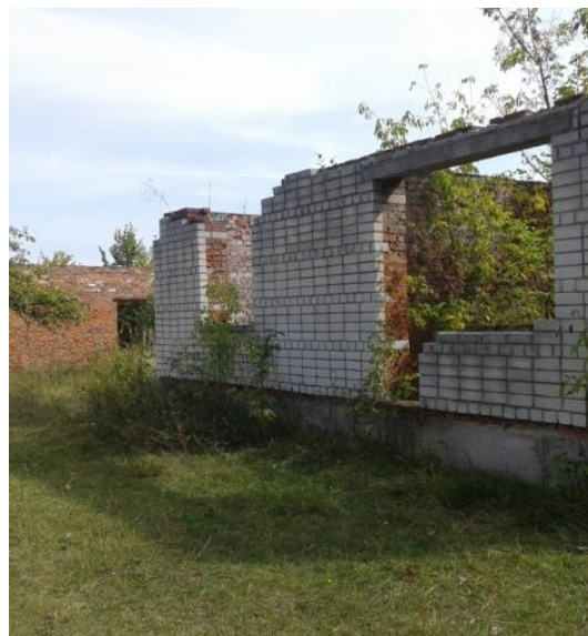
Одноквартирний житловий будинок з господарським блоком
