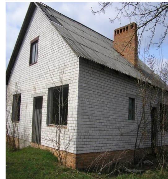
Незавершене будівництво житлового будинку
