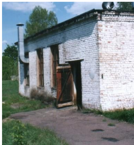
Будівля машинного відділення
